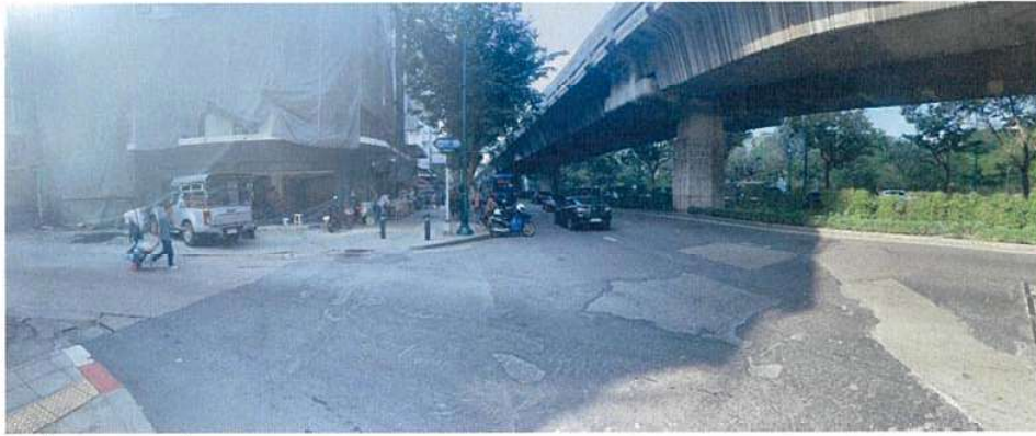
จุดถ่ายภาพที่ 4 : สภาพทั่วไปถนนพหลโยธิน บริเวณแยกเข้าซอยพหลโยธิน 18/2 (ซอยเฉยพวง) (ทางเข้า-ออกที่ 2)
