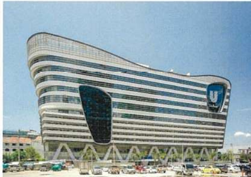
สภาพทั่วไปด้านหน้าอาคาร
