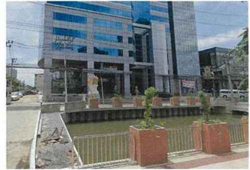
สภาพทั่วไปภายนอกอาคาร
