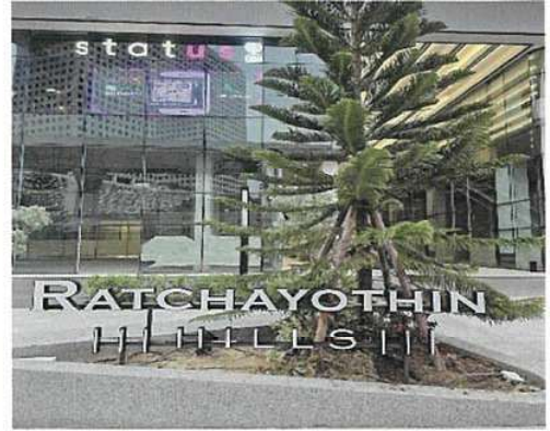
สภาพทั่วไปด้านหน้าอาคาร
