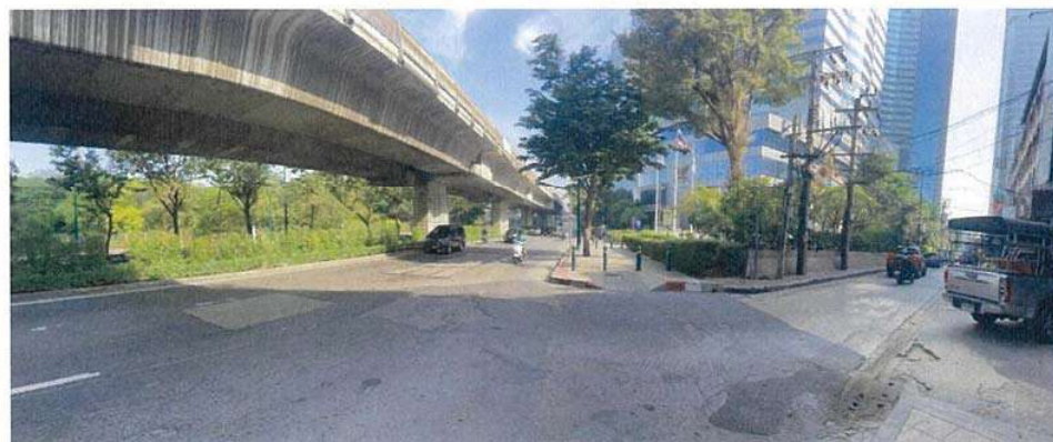
จุดถ่ายภาพที่ 3 : สภาพทั่วไปถนนพหลโยธิน บริเวณแยกเข้าซอยพหลโยธิน 18/2 (ซอยเฉยพวง) (ทางเข้า-ออกที่ 2)
