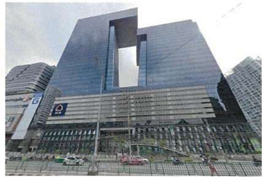
สภาพทั่วไปภายนอกหน้าอาคาร
