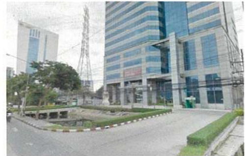
สภาพทั่วไปภายนอกอาคาร
