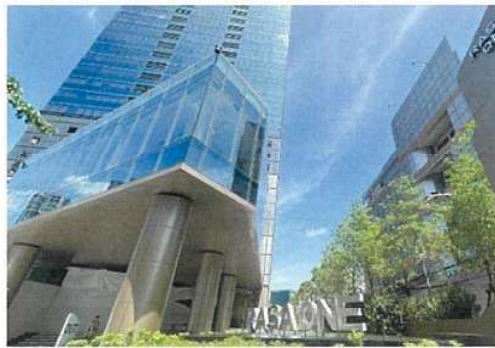
สภาพทั่วไปภายนอกหน้าอาคาร
