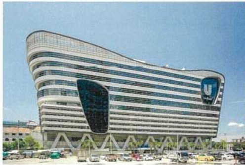
สภาพทั่วไปด้านหน้าอาคาร
