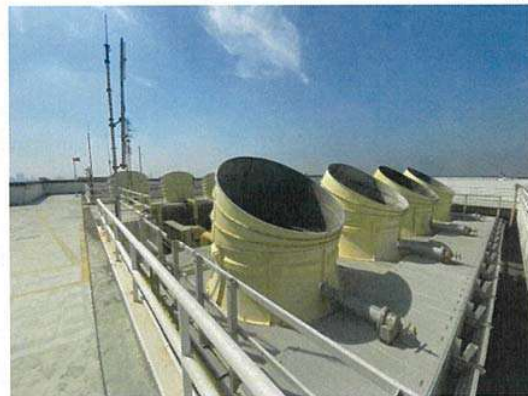
สภาพทั่วไปทรัพย์สินที่ประเมินมูลค่า / Cooling Tower
