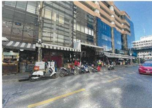
สภาพทั่วไปบริเวณรอบอาคาร
