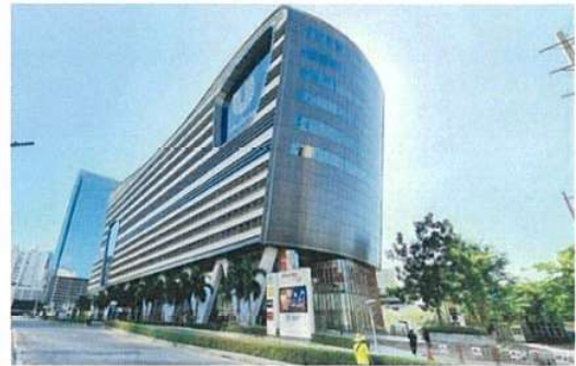
สภาพทั่วไปด้านหน้าอาคาร
